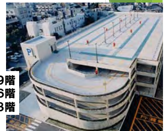
神戸大学医学部付属病院立体駐車場
