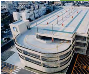
神戸大学医学部付属病院立体駐車場
