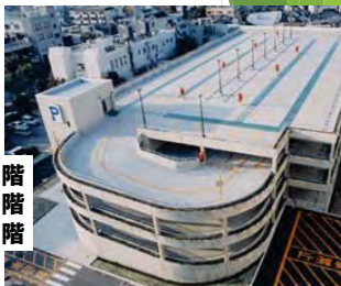
神戸大学医学部付属病院立体駐車場
