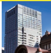
高層ビル内ホテル (実験対象施設)
